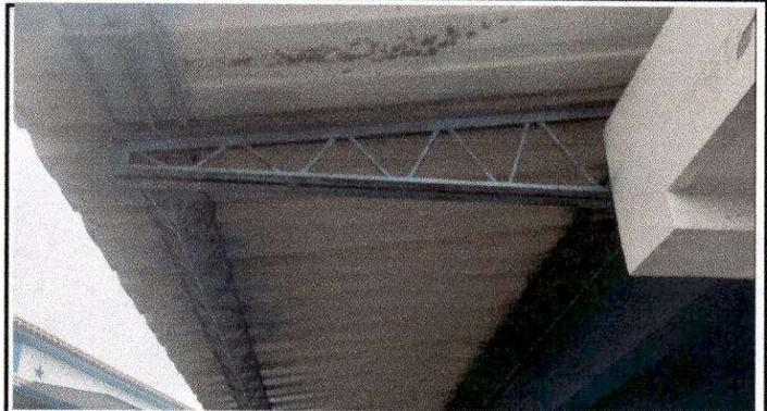
Foto 2: Estado actual de 2 hojas de lámina del módulo 11 y sustitución de lámina troquelada aluzinc calibre 26
