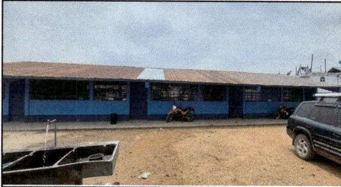
Foto 1: Estado actual de la lámina del techo del módulo 6, 7, 8, y 9 y sustitución de lámina troquelada aluzinc calibre 26 de los módulos
